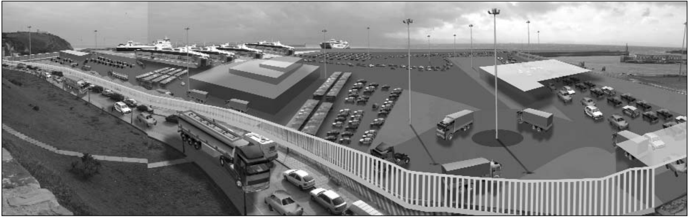
Vista desde el Miramar, con simulación del megapuerto y frontera
