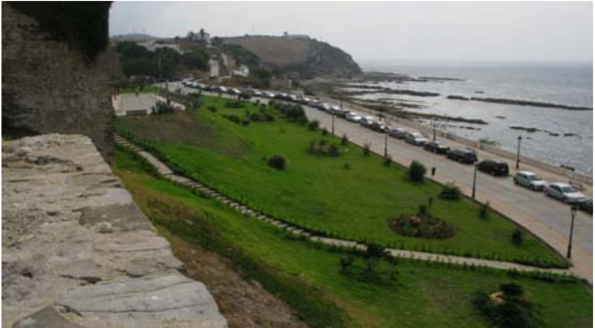
Vista desde la Muralla medieval. Abajo: frente litoral amurallado de Tarifa, donde se ubica el proyecto.
